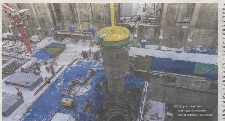
Корпус реактора перемещают тяжелым гусеничным краном Liebherr
