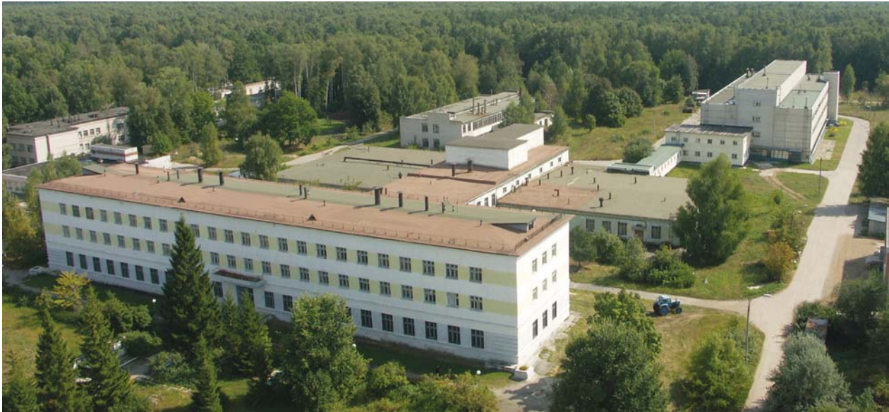
Рис. 3.24. Общий вид здания отделения реакторного материаловедения
